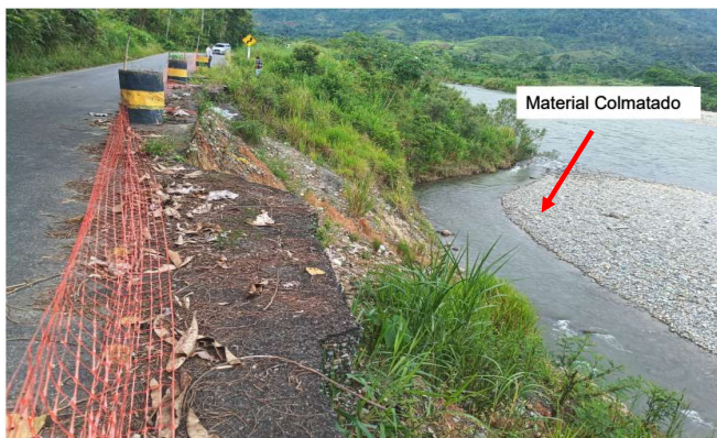
FIGURA N° 02: SE PUEDE OBSERVAR COMO EL RIO ESTA SOCABANDO LA CARRETERA DEL SECTOR LA GRANJA
